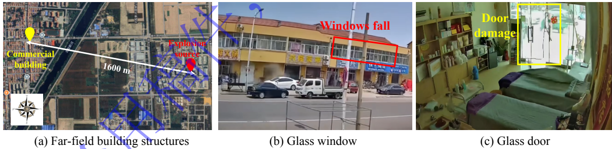
图5 远场建筑结构的损伤破坏 [20]
